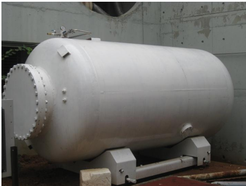
Εικόνα 3.3: Η αποθήκη καθαρού αερίου (Buffer)
