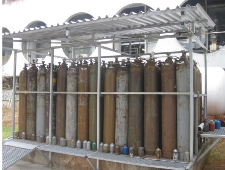
Εικόνα 3.5: Οι 98 φιάλες της αποθήκης ακαθάρτου αερίου
