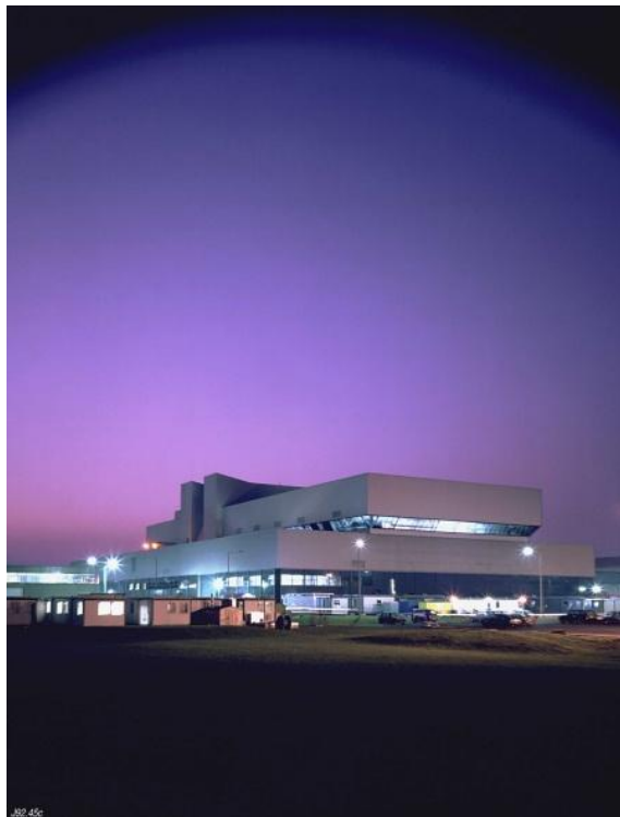
Σχήμα 1.10 Εξωτερική όψη των εγκαταστάσεων JET [ B.2.25. ]
