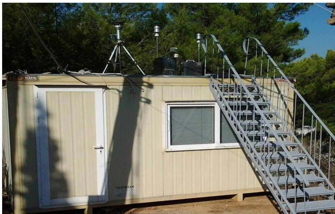
Εικόνα 3.2 Container φύλαξης TEOM. Στη στέγη διακρίνονται οι κεφαλές των δειγματοληπτών.
