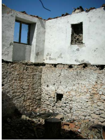
ΕΙΚΟΝΑ 4: ΚΑΥΣΗ ΞΥΛΙΝΟΥ ΠΑΤΩΜΑΤΟΣ-ΔΙΑΚΡΙΝΟΝΤΑΙ ΟΙ ΘΕΣΕΙΣ ΕΔΡΑΣΗΣ ΤΩΝ ΞΥΛΙΝΩΝ ΔΟΚΩΝ
