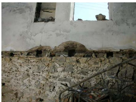
ΕΙΚΟΝΑ 3: ΚΑΥΣΗ ΞΥΛΙΝΟΥ ΠΑΤΩΜΑΤΟΣ-ΔΙΑΚΡΙΝΟΝΤΑΙ ΟΙ ΘΕΣΕΙΣ ΕΔΡΑΣΗΣ ΤΩΝ ΞΥΛΙΝΩΝ ΔΟΚΩΝ
