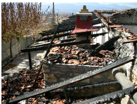
ΕΙΚΟΝΑ 2: ΚΑΥΣΗ ΚΑΙ ΚΑΤΑΡΡΕΥΣΗ ΞΥΛΙΝΟΥ ΣΤΕΓΑΣΤΡΟΥ
