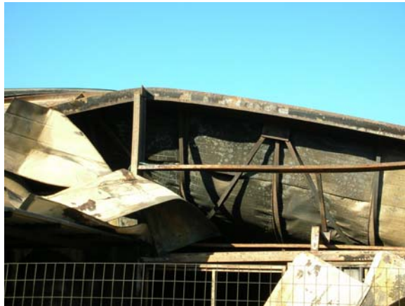
ΕΙΚΟΝΑ 12: ΛΕΠΤΟΜΕΡΕΙΑ ΠΑΡΑΜΟΡΦΩΜΕΝΟΥ ΜΕΤΑΛΛΙΚΟΥ ΦΟΡΕΣ ΣΤΕΓΗΣ
