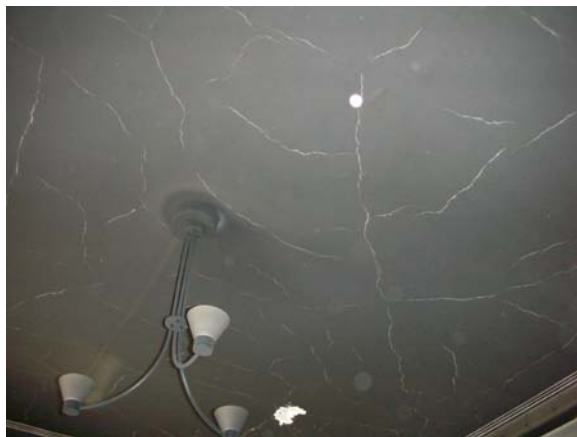
ΕΙΚΟΝΑ 5: ΡΩΓΜΕΣ ΣΕ ΠΛΑΚΑ ΥΠΟΚΕΙΜΕΝΗ ΞΥΛΙΝΗΣ ΣΤΕΓΗΣ Η ΟΠΟΙΑ ΚΑΗΚΕ
