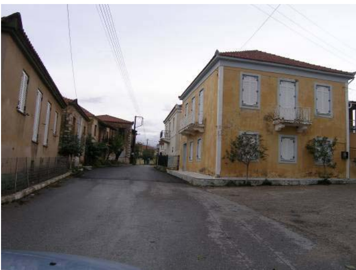
Εικ. 6,7,8: Αρχιτεκτονικός χαρακτήρας και παρεμβάσεις στο δημόσιο χώρο οικισμών της περιοχής μελέτης.
