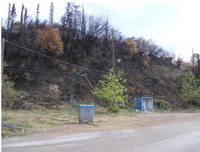
Εικόνα 3-25. Άποψη της σημερινής διαμόρφωσης στο ανάντη τμήμα της κατολίσθησης στο χωριό Καλίδωνα.
