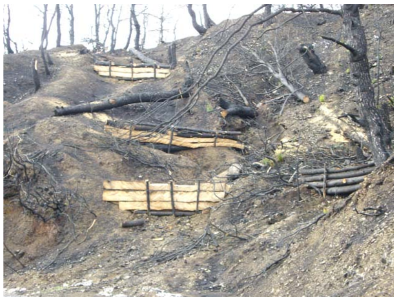
Εικόνα 8-2. Διάταξη ξυλοφραγμάτων σε ορεινή ζώνη της περιοχής.
