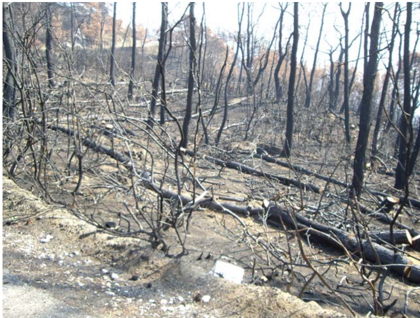
Εικόνα 8-1. Κορμοδέματα σε ορεινό πρανές με καμένη δασώδη φυτοκάλυψη.
