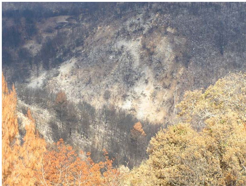
Εικόνα 3-15. Αστοχία φυσικού ασβεστολιθικού πρανούς ανάντι της κοίτης του ρέματος Άνυδρος (θέση Γουρλόβουνα)
