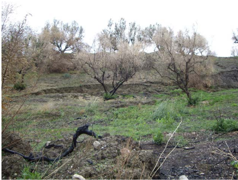
Εικόνα 3-22. Μερική άποψη της ζώνης αστοχιών στο κατάντι πρανές του δρόμου. Διακρίνεται εδαφική θραύση
