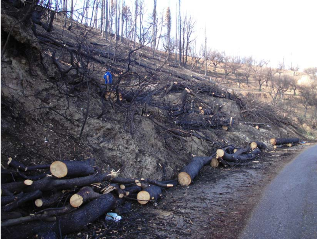
Εικόνα 17. Εργασίες κατασκευής κορμοδεμάτων έξω από το χωριό Καλίδονα.
