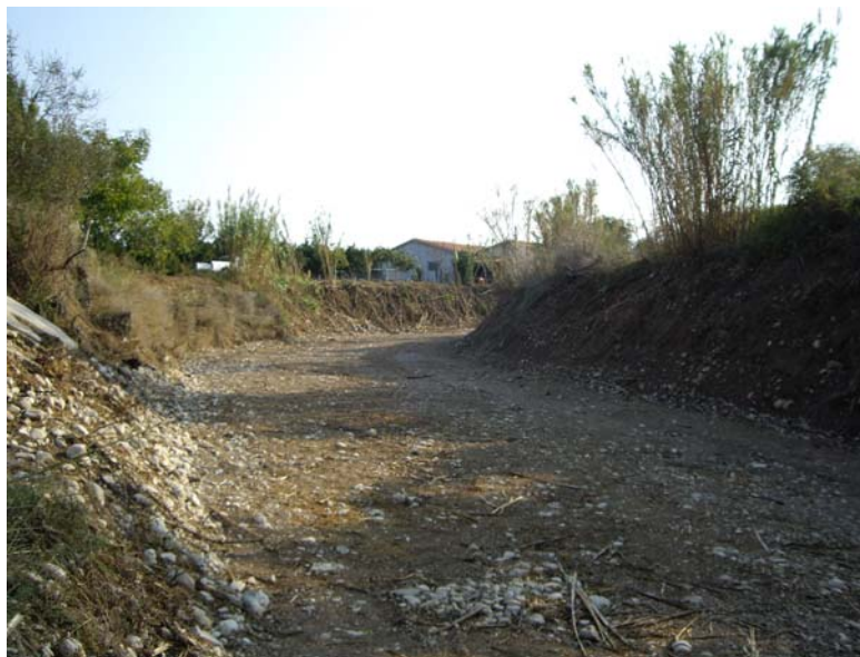
Εικόνα 8-4. Καθαρισμός και διεύρυνση της κοίτης κύριου υδρογραφικού άξονα.
