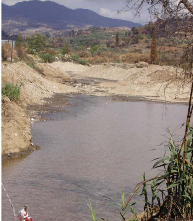
Εικόνα 15. Ανθρωπογενής επέμβαση στη κοίτη του ρέματος Ακίδα. Διατάραξη της φυσικής ισορροπίας στις κοίτες των ρεμάτων οδηγεί σε φαινόμενα έντονης διάβρωσης, αυξάνοντας τη στερεοπαροχή στο κατάντη τμήμα αυτών.
