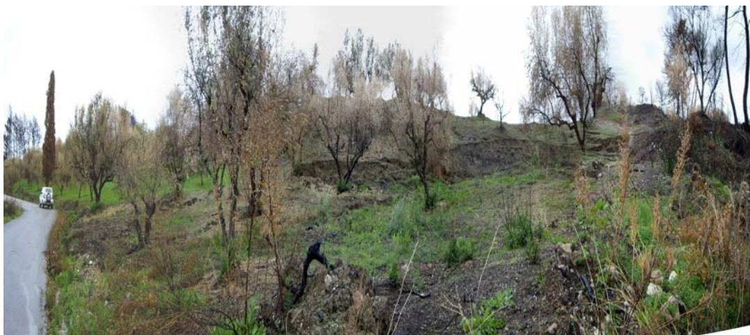
Εικόνα 3-23. Γενική άποψη της ζώνης αστοχιών στη θέση Ασίκελος.
