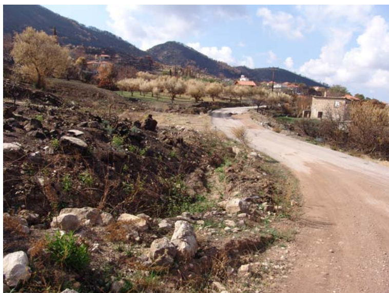
Εικόνα 3-16 Γενική άποψη της αστοχίας ανατολικά του Χρυσοχωρίου.
