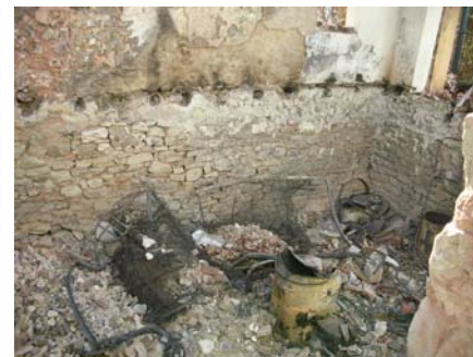
Καύση ξύλινων πατωμάτων. Διακρίνονται οι θέσεις έδρασης των ξύλινων δοκών στην τοιχοποιία
