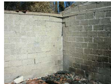
Κτήριο από τσιμεντόλιθους
