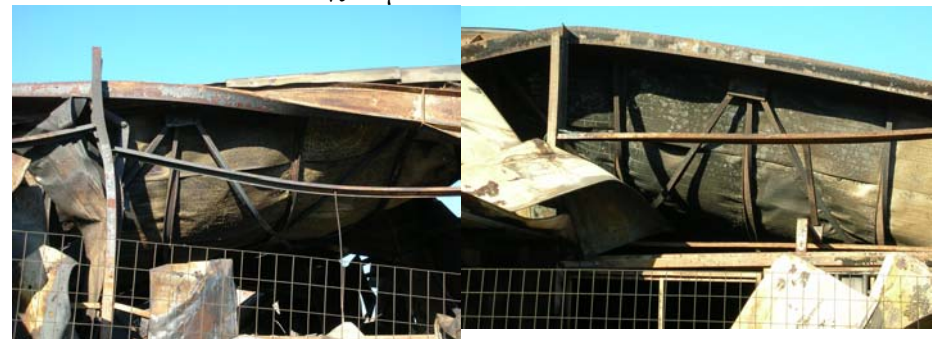
Αστοχία μεταλλικών ζευκτών
