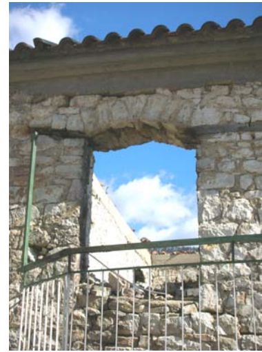
Η παρουσία διαζώματος Ω.Σ. απέτρεψε την αποκόλληση και κατάρρευση του (υπό πολύ μικρά φορτία) ανακουφιστικού τόξου.
