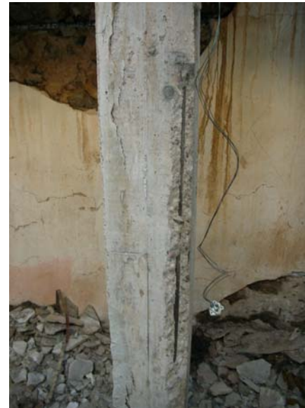
Αποκόλληση της επικάλυψης στην περιοχή διαμήκους διαβρωμένης ραβδου οπλισμού.
