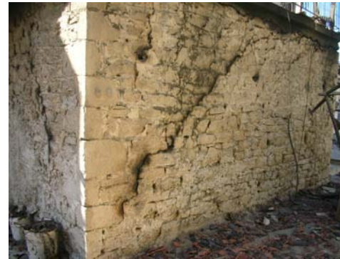
Διατμητικές ρωγμές σε πεσσούς. Διακρίνεται η πλάκα Ω.Σ. στην στάθμη της οροφής ισογείου.
