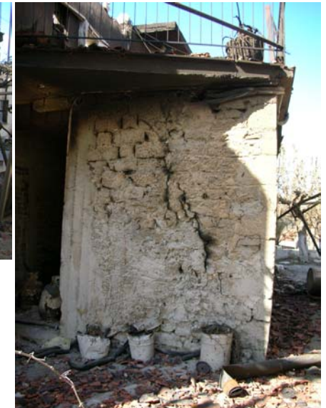
Διατμητικές ρωγμές σε πεσσούς. Διακρίνεται η πλάκα Ω.Σ. στην στάθμη της οροφής ισογείου.
