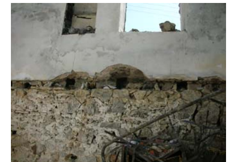
Καύση ξύλινων πατωμάτων. Διακρίνονται οι θέσεις έδρασης των ξύλινων δοκών στην τοιχοποιία
