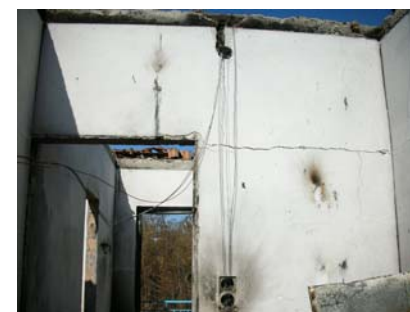
Κτήριο από οπτοπλινθοδομή με διαζώματα από Ω.Σ.
