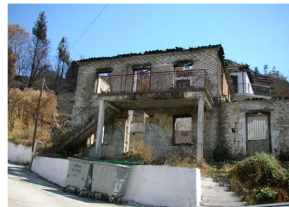
Κτήριο με ισόγειο από λιθοδομή και όροφο από οπτοπλινθοδομή.
