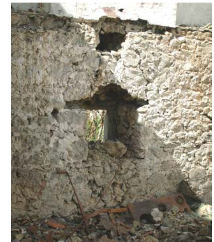
Καύση ξύλινου υπερθύρου. Κατάρρευση ανακουφιστικού τόξου.
