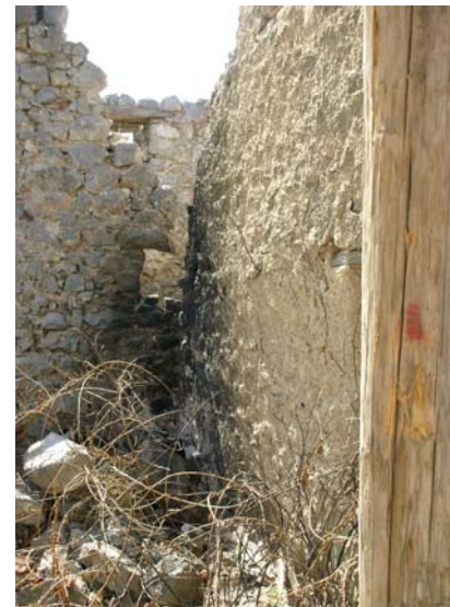
Οριζόντιες ρωγμές στην διεπιφάνεια σκυροδέματος και τοιχοποιίας
