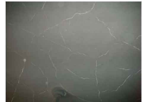
Στο κτήριο της φωτογραφίας (αριστερά), πάνω από την πλάκα οροφής ορόφου, υπήρχε ξύλινη στέγη με κεραμίδια. Η καύση της στέγης προκάλεσε στην υποκείμενη πλάκα το δίκτυο των (διαμπερών) ρωγμών, οι οποίες φαίνονται στην φωτογραφία δεξιά..
