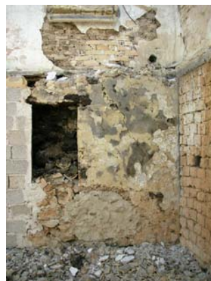
Κτήριο με τοίχους από ωμοπλίνθους, λίθους, τσιμεντόλιθους και οπτοπλίνθους
