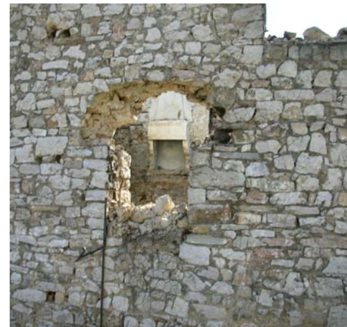
Καύση ξύλινου υπερθύρου. Κατάρρευση ανακουφιστικού τόξου.
