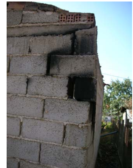
Οριζόντιες ρωγμές στην διεπιφάνεια σκυροδέματος και τοιχοποιίας
