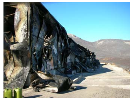
Αστοχία μεταλλικών ζευκτών
