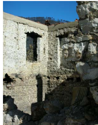
Η παρουσία διαζώματος Ω.Σ. απέτρεψε την αποκόλληση και κατάρρευση του (υπό πολύ μικρά φορτία) ανακουφιστικού τόξου.
