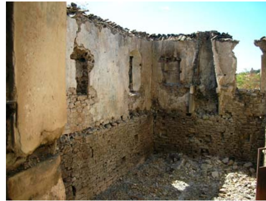
Αποκόλληση και πτώση επιχρισμάτων
