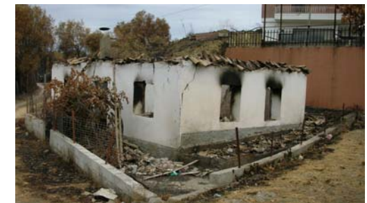
Κτήριο από ωμοπλινθοδομή
