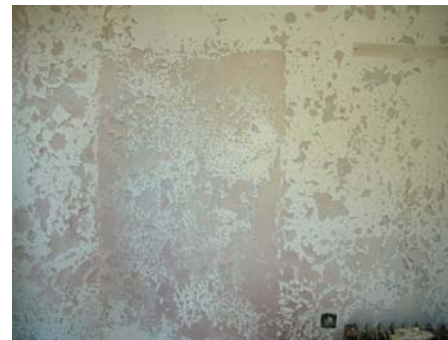
Αλλαγή χρώματος του επιχρίσματος
