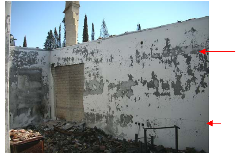
Οριζόντιες ρωγμές στην διεπιφάνεια σκυροδέματος και τοιχοποιίας
