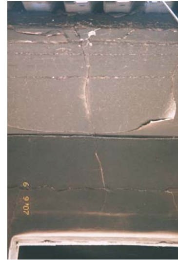
Μεγάλου εύρους ρωγμή στην δοκό και στην πλάκα.
